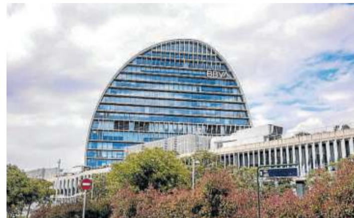
Fachada de la sede de BBVA en Madrid. Foto: E.P.
